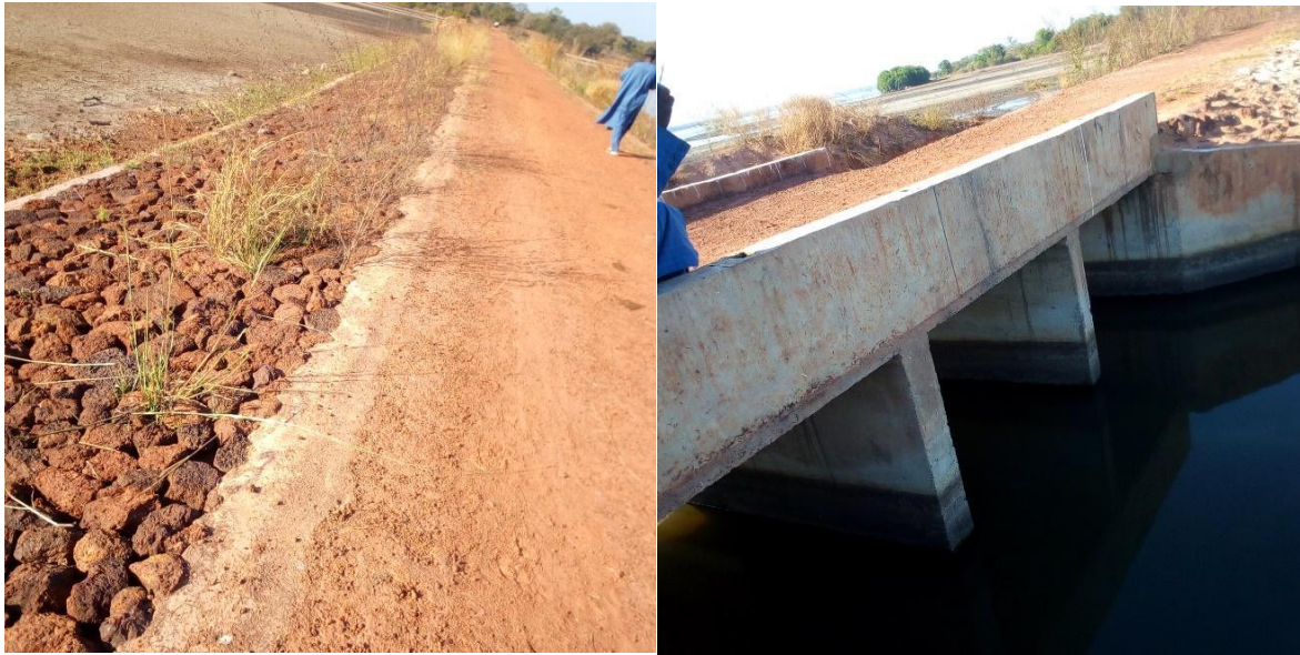
Photo 7 : Digue antisel à Manconomba (Source : F. Seck, 2023)
